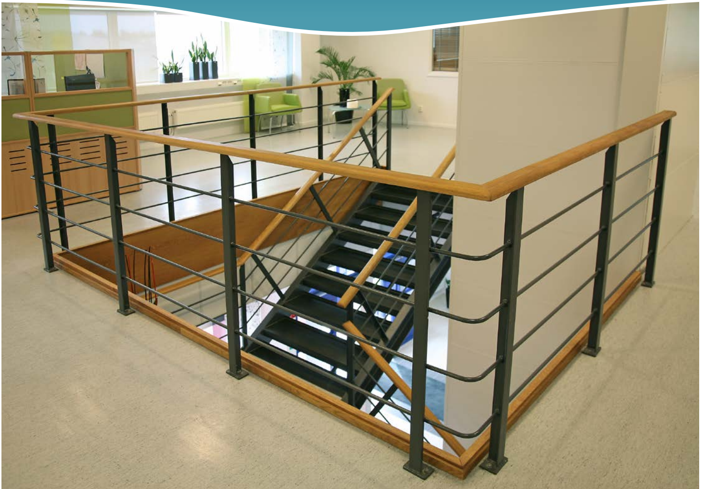
Rak trappa i specialutförande monterad i kontorsdel på logistikcenter. Trappstegen är belagda med klinkers och kontrastmarkeringar på första och sista steget i varje trapplöp. Handledare av ek. Floby Durk har utfört montaget.
