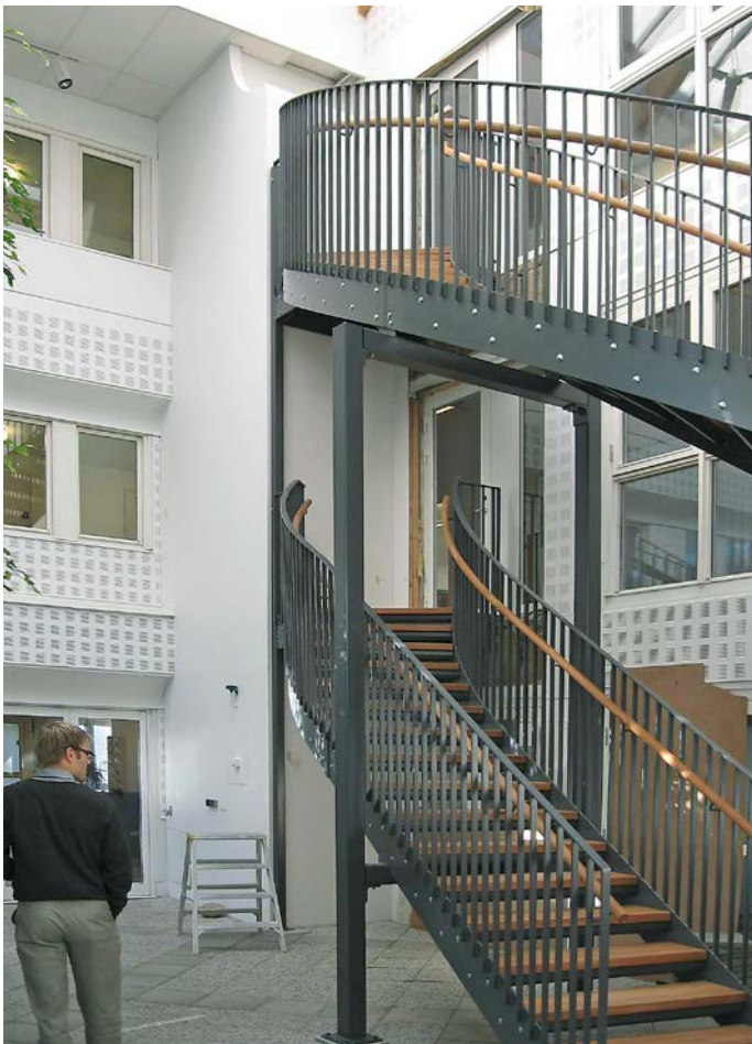
Vindeltrappa med steg av ek. Barnsäkert räcke med invändig handledare av ek.
