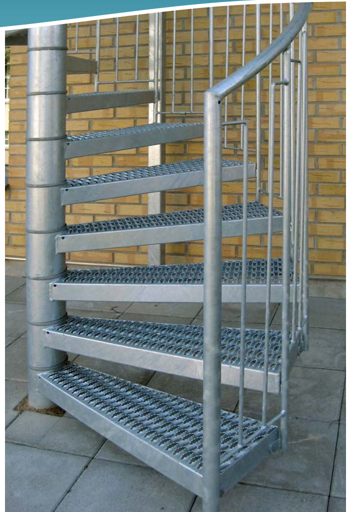
Spiraltrappa monterad i Ulricehamn. Trappsteg och plan av slitsdurk. Barnsäkert räcke.
