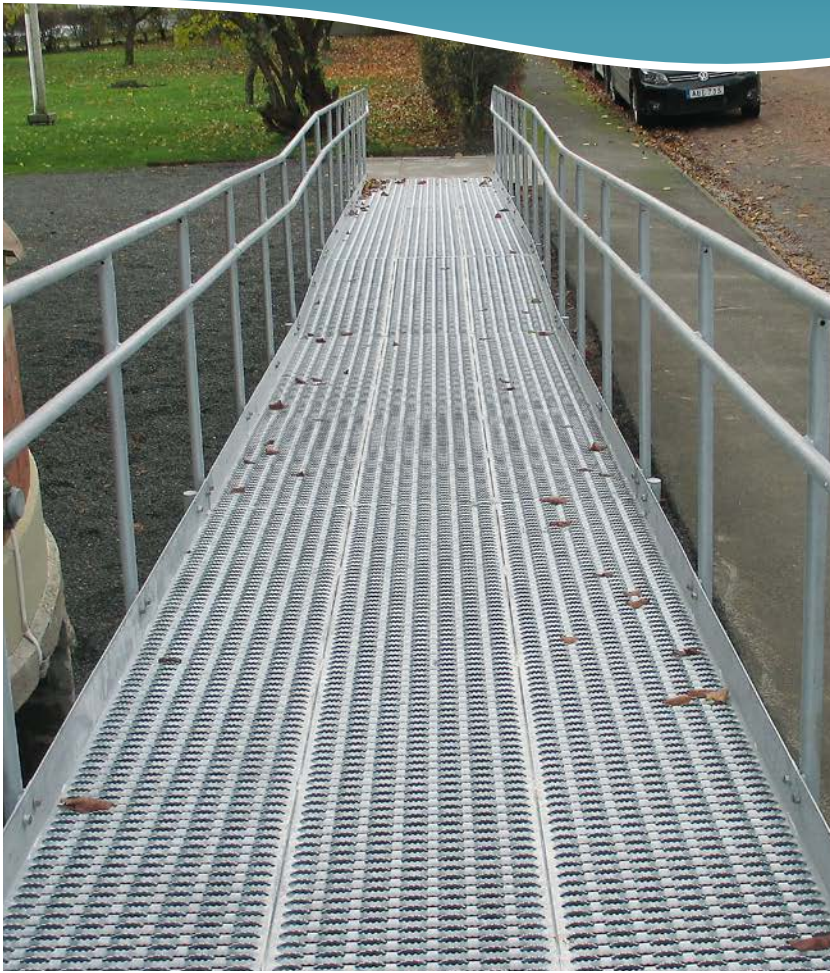
IOGT i Skövde. En handikappramp med gångplan av halksäker slitsdurk. Tillverkad och monterad av Floby Durk AB. Vi tillverkar även ramper i gallerdurk.
