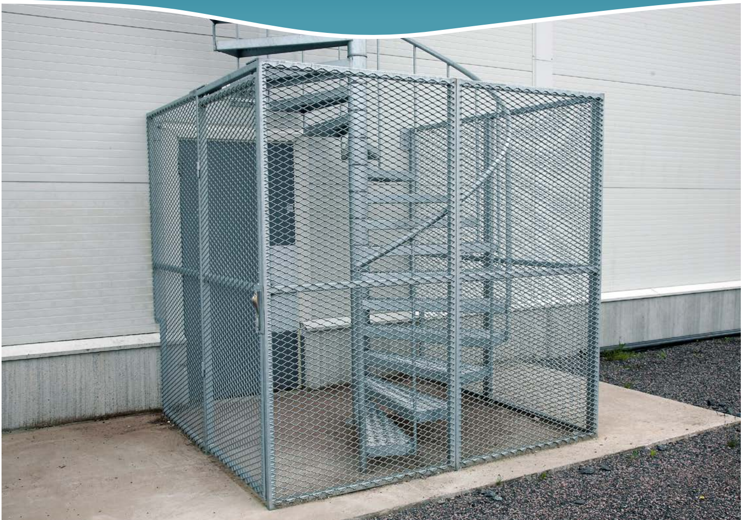
Spiraltrappa med skyddsbur av sträckmetall.
