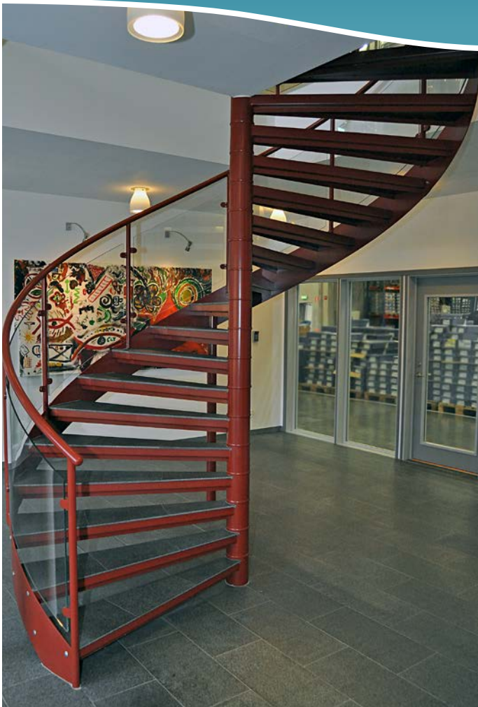
I-Data i Värnamo. Spiralltrappa med vangstycke och klinkerbelagda trappsteg. Glasen i räcket är formade efter trappradien.
