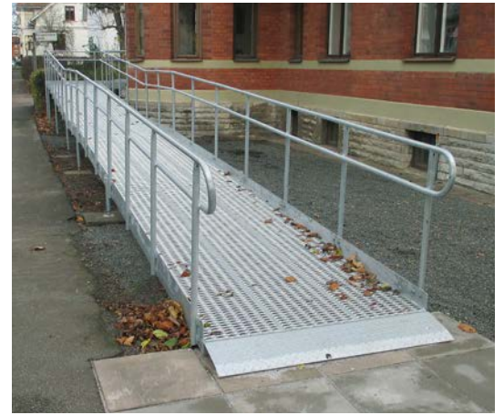
IOGT i Skövde. En handikappramp med gångplan av halksäker slitsdurk. Tillverkad och monterad av Floby Durk AB. Vi tillverkar även ramper i gallerdurk.
