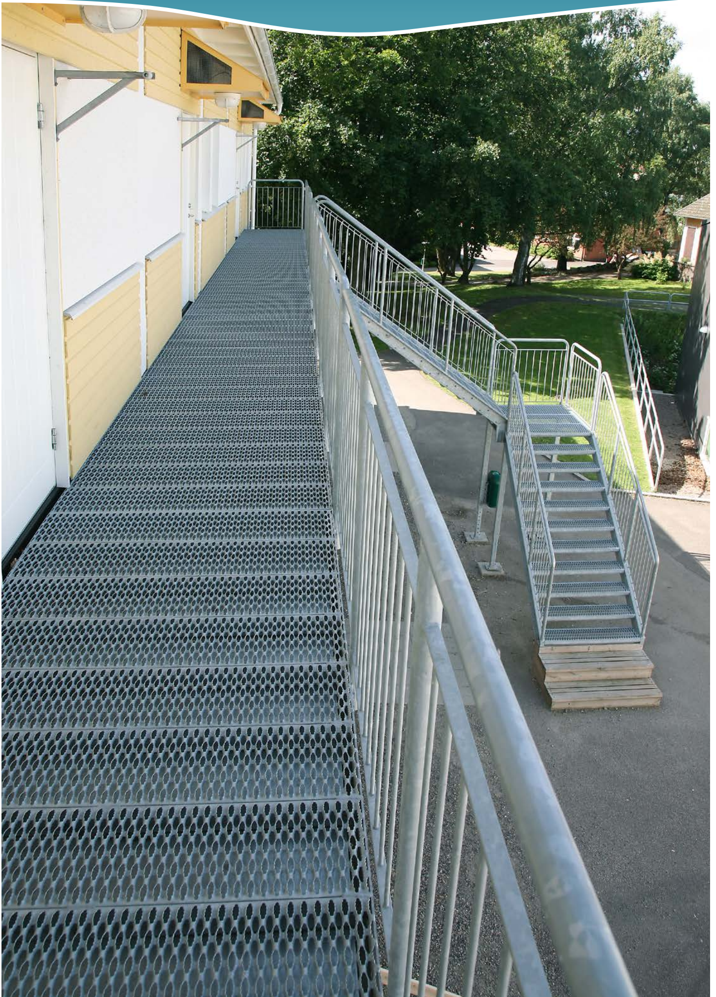
Gymnasieskola i Falkenberg. Floby Durk har levererat loftgångar, raka trappor och spiraltrappor av slitsdurk till Temporent AB. Temporent AB erbjuder temporär lokaluthyrning i modulbyggnader.
