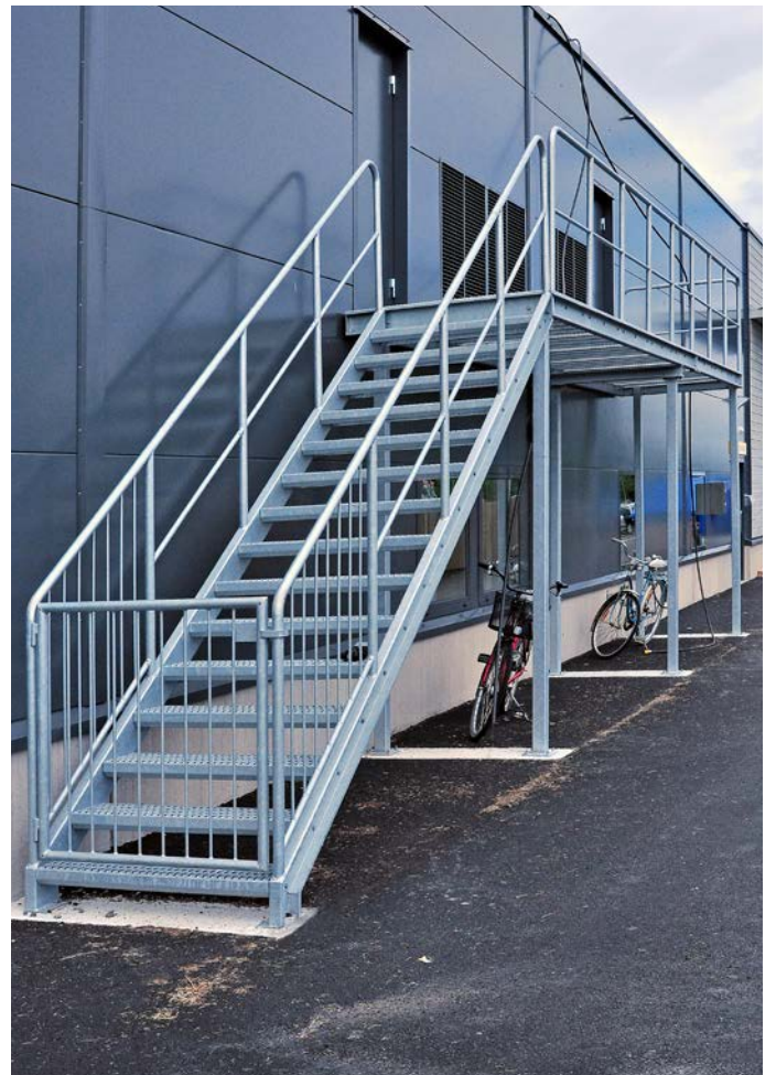
Rak trappa med grind.
