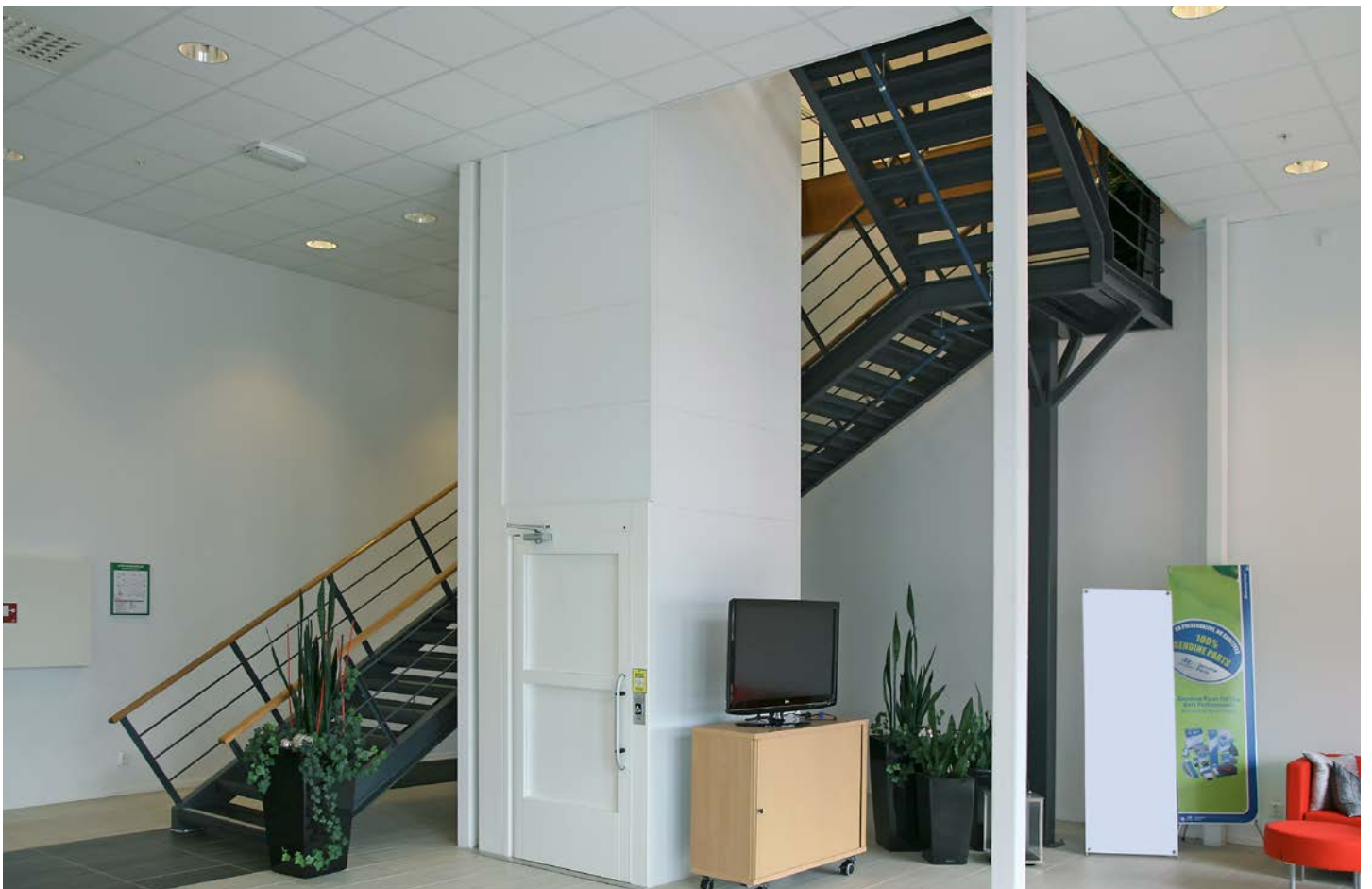
Rak trappa i specialutförande monterad i kontorsdel på logistikcenter. Trappstegen är belagda med klinkers och kontrastmarkeringar på första och sista steget i varje trapplöp. Handledare av ek. Floby Durk har utfört montaget.
